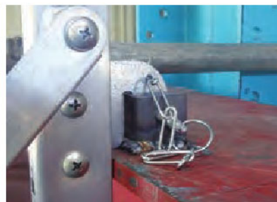
先付けベース・ベース用フック 取付状態
