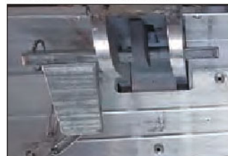
NKSHクサビ打ち込み後(設置状態)
