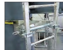
はしご振れ止めバンド取付け例
