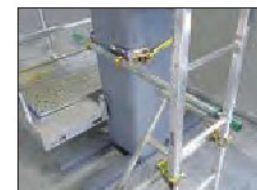
LH用NKSタラップ接続金具取付け例
