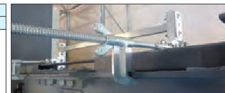
梁幅 W=150mmに設置した状況
