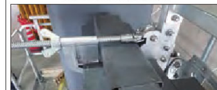
梁幅 W=200mmに設置した状況
